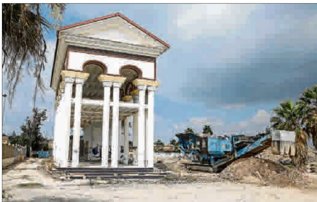
Las excavadoras esperan para demoler lo que queda de la antigua Arabesco. MAO
