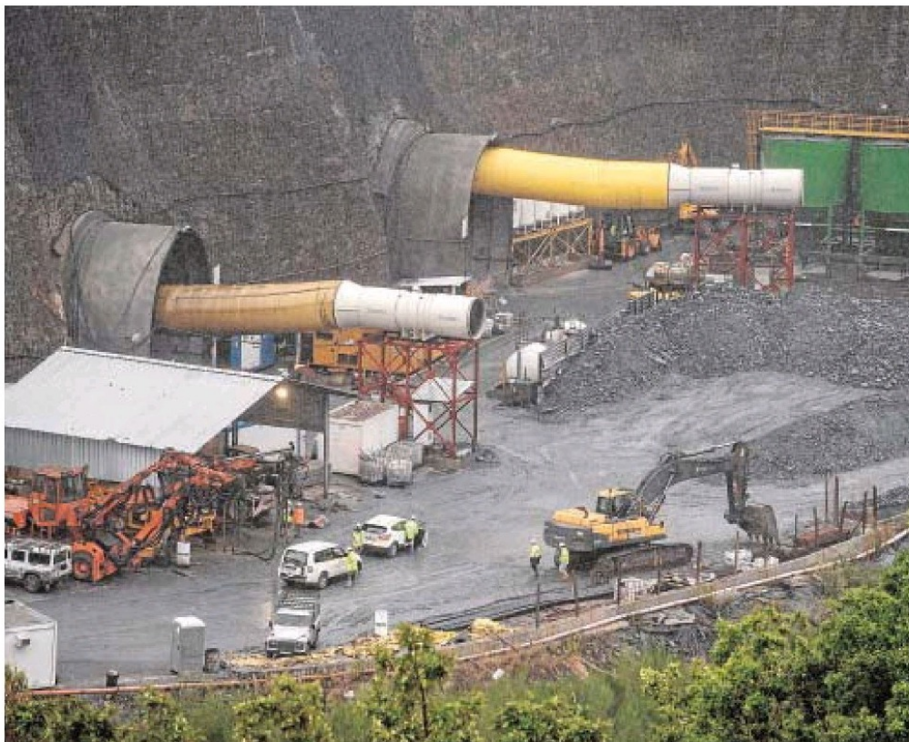
Vista general de las obras del AVE en el túnel de O Corno, en Laza (Orense)
